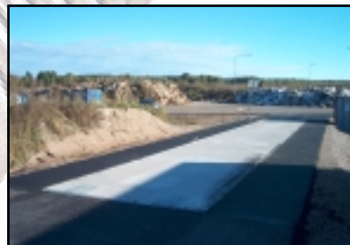
Avesta Kommunes genbrugsplads, Sverige. Model DE nedbygget 24 x 3 meter. Inklusiv vej-selv terminal og BridgeMaster vejsoftware for affaldsregistrering.
